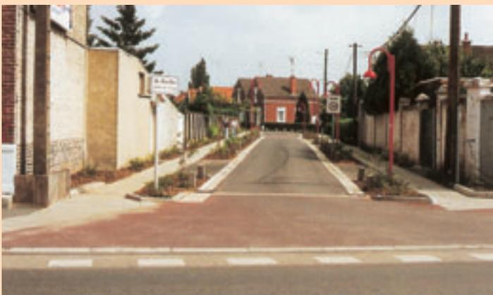
Traitement de l'entrée d'une zone 30 au droit d'un carrefour (Rennes): surélévation complète du carrefour traité avec un revêtement visible de loin et réduction de l'emprise de la chaussée sur chaque voie d'entrée par des avancées de trottoir. ▼
