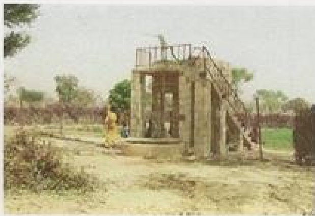
Puits et châteaux d'eau
