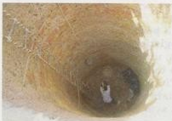
Creusements de puits
